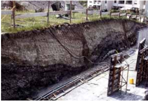
Abb. 8 (links): Westwand der Baugrube am Gehenbühl in Korntal – zwischen den Sediment-verfüllten Spalten 2 (Mitte) und 3 (rechts) ist direkt über der Grubensohle eine Gipsbank angeschnitten (Foto TH. RATHGEBER, Sommer 1990).
